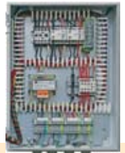
Schutzsteuerung / Contactor control
